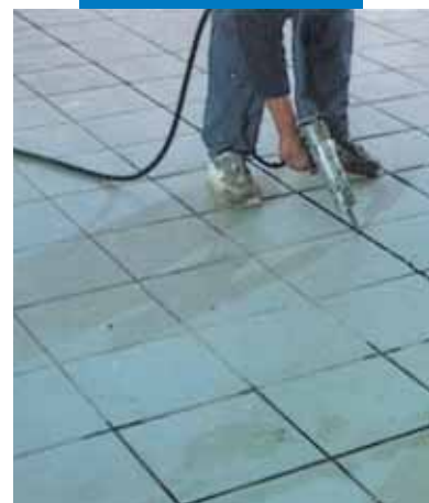
Kerámia padlóburkolat tömítése Mapesil AC-vel
