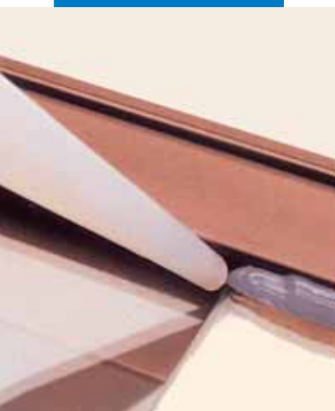
Alumínium ablakkeret tömítése Mapesil AC-vel
