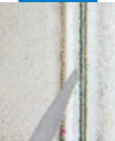
U-profilú üveg tömítése
