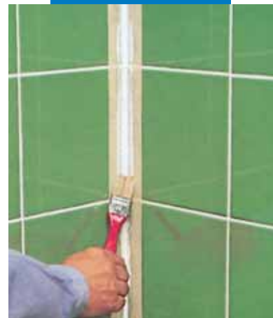
Hézagkitöltés simítása szappanos vízzel és kis ecsettel
